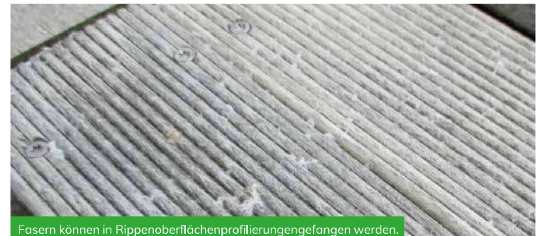
Fasern können in Rippenoberflächenprofilierungengefangen werden.
